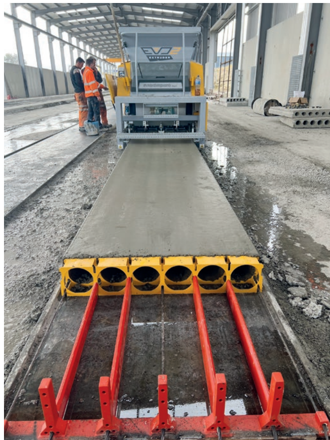
Estrusore EVO2 operativo in fase di getto
